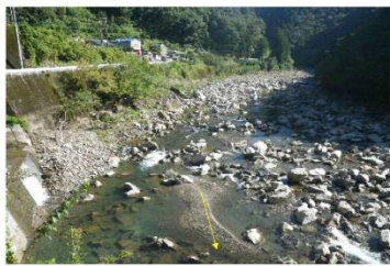
奈半利川(轟橋より上流を望む)
