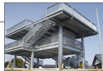
〔津波避難タワー〕
