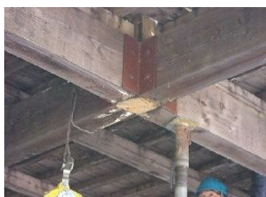
図25-1 桁受部・補修前
