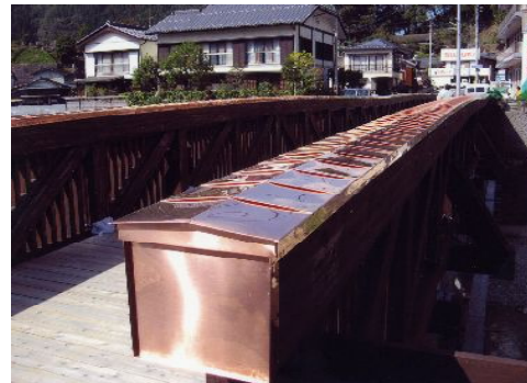
図9 高欄の雨水対策
