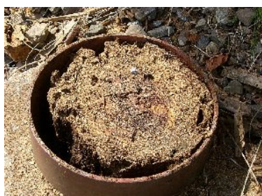
図24-1 脚元部・補修前
