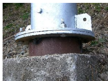
図24-2 脚元部・補修後
