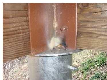
図25-2 桁受部・補修後
