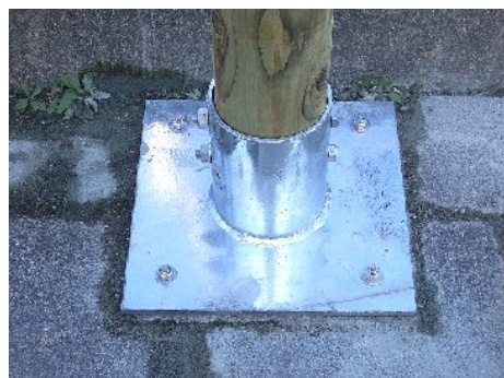
図30 施工直後のパイプ付プレートの状況
