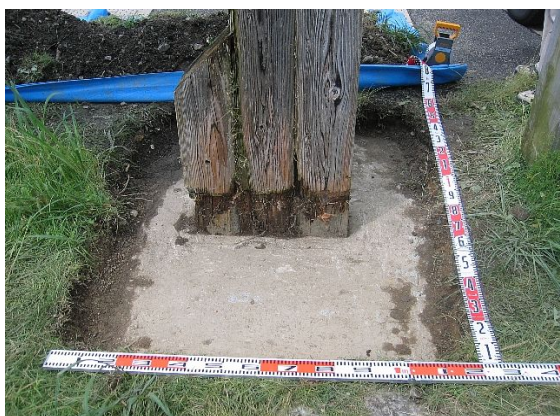
図11 案内板の柱・地際付近の調査状況
