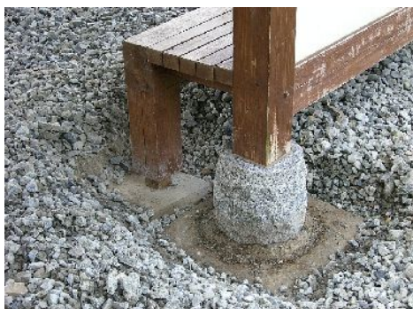
図8 地際部の腐朽菌対策
