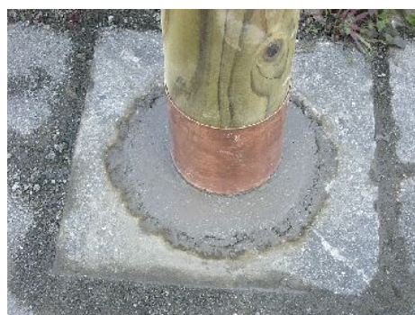
図31 施工直後の銅板の状況
