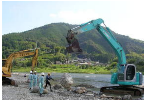
近自然工法 施工の様子（いの町柳瀬地区）
