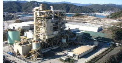
住友大阪セメント株式会社高知工場2号発電設備
