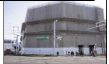
社屋の耐震化工事
