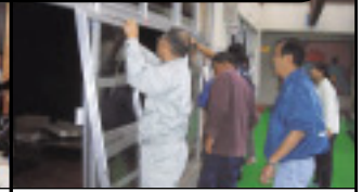
ガラスの飛散防止対策（提供：安芸市）
