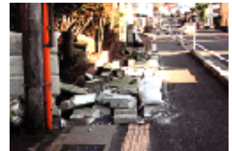
ブロック塀の倒壊 (新潟県中越地震時の新潟県小千谷市)
