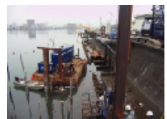
堤防基礎部で耐震補強を実施 (高知市国分川)
