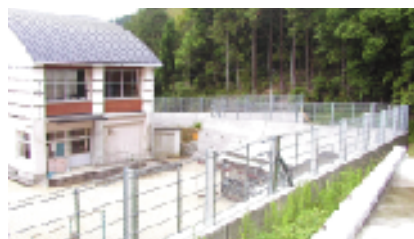
急傾斜地崩壊対策(避難所の保全)
