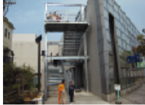
既存の建築物に外付け階段をつけた津波避難ビル（提供 香南市）
