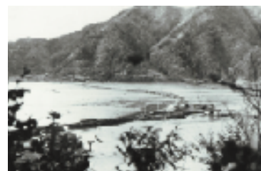
須崎市新荘駅付近の津波浸水 (提供 須崎市)
