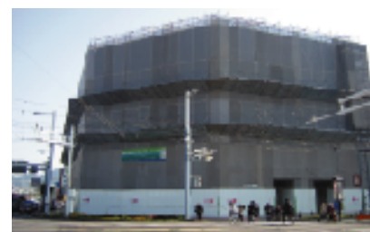
社屋の耐震化工事
