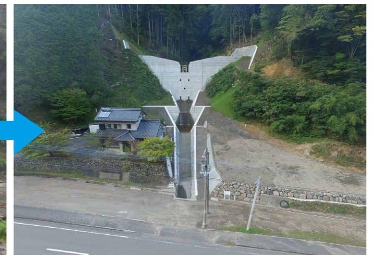
河主谷川特定緊急砂防事業(栲原町下西の川)
