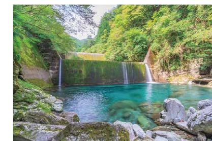
安居川砂防えん堤
