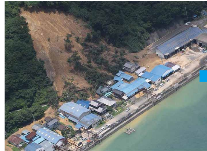
平成30年豪雨災害によるがけ崩れ(宿毛市大島地区)
