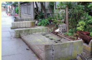
地震により、倒壊したブロック塀 (平成19年 新潟県中越沖地震) 写真提供:埼玉県
