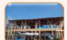
土佐材の建築
