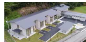
CLT建築物(県立林業大学校)
