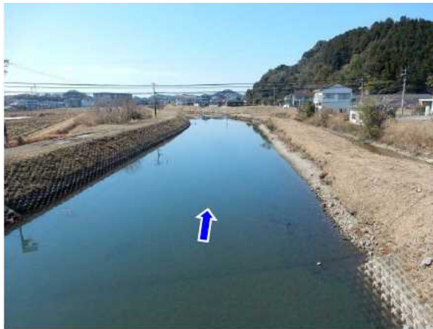
現在の河道状況（1k000付近）
