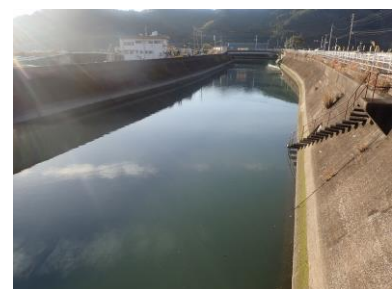
生きものの生息環境が悪化した河川改修
