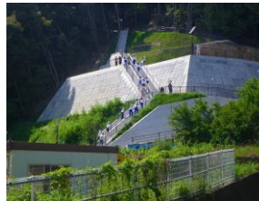
<津波避難施設>
