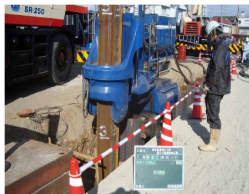
堤防の耐震補強を実施（国分川）
