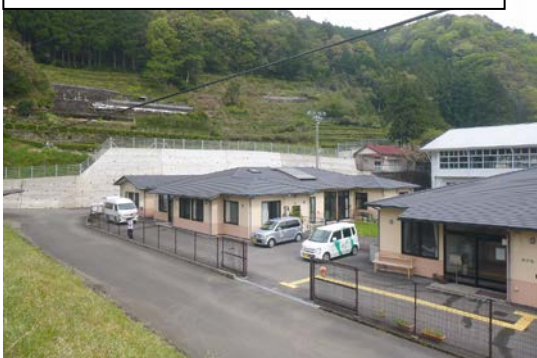
人家8戸及び避難場所、要配慮者利用施設を 保全した区域（高岡郡津野町）
