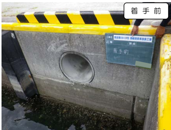
〔管渠の閉鎖の例〕
