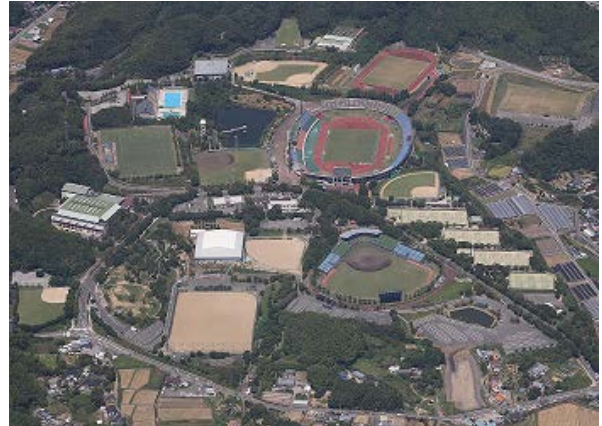
春野総合運動公園（水泳場のエレベーター設置）
