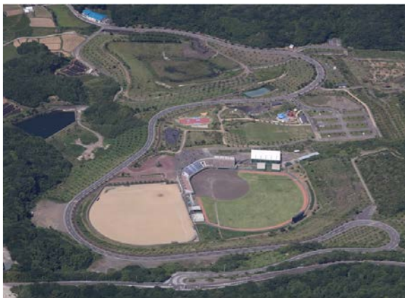
室戸広域公園（屋内運動場建築主体工事）
