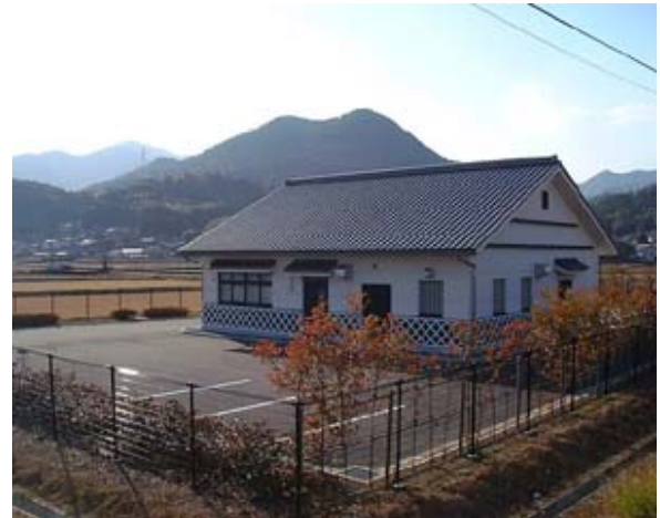
污水処理施設
