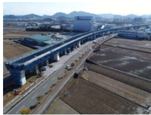
高知東部自動車道 高知南国道路
