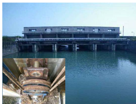
老朽化が進行した水門を改築（後川放水路）
