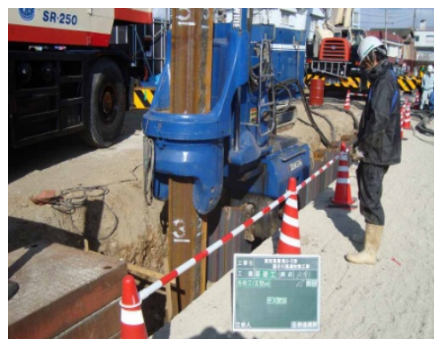
堤防の耐震補強を実施（国分川）
