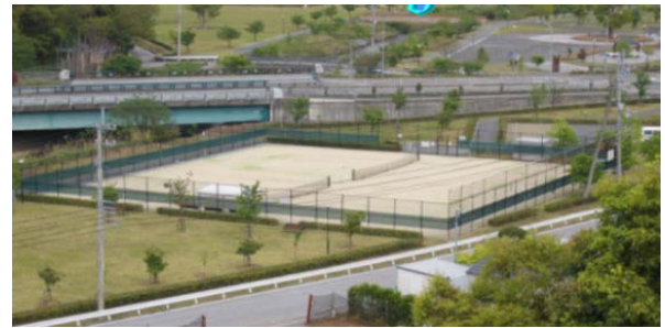
池公園 (テニスコートの改修)
