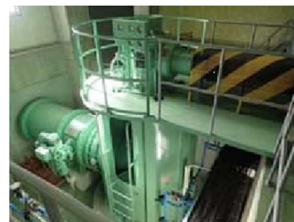
老朽化が進行したポンプを更新（本江田排水機場）
