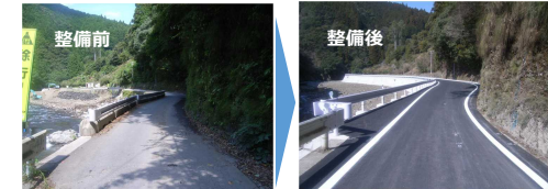
1.5車線の道路整備（県道畑山橋ノ木線）
