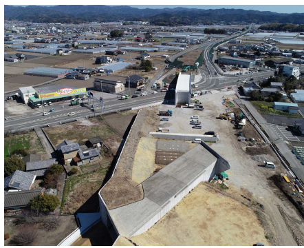
高知東部自動車道 南国安芸道路 (香南市)
