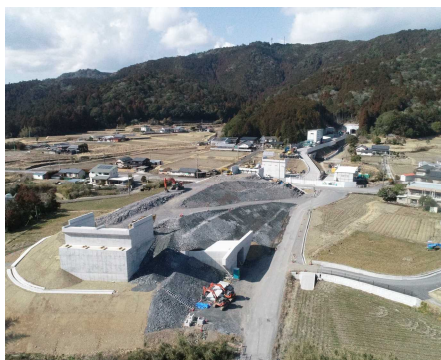
四国横断自動車道 窪川佐賀道路 (四万十町)
