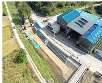
河川改修を実施（奥田川）
