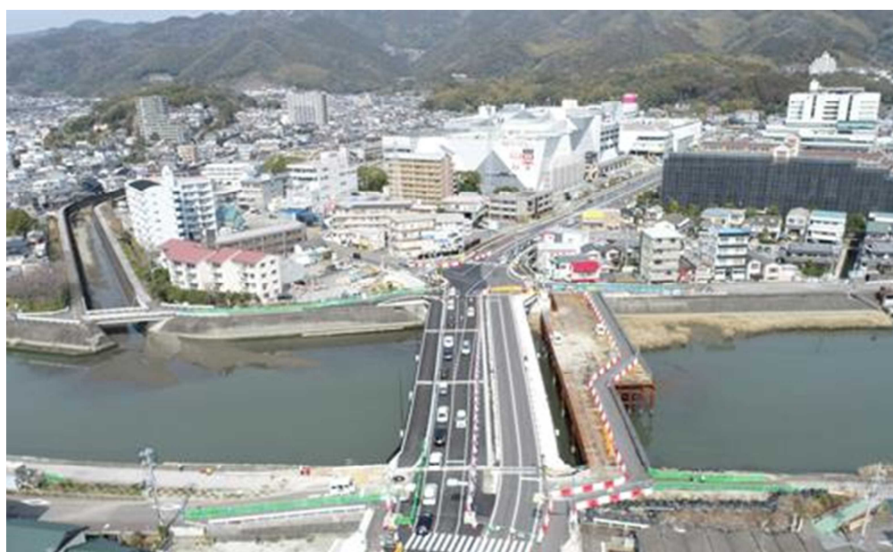
高知駅秦南町線（北・南工区）の整備状況
