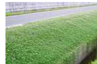
防草緑化工法
