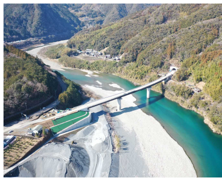
高知松山自動車道 越知道路2工区 (越知町)
