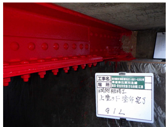
県道奈比賀川北線（さる谷橋）
