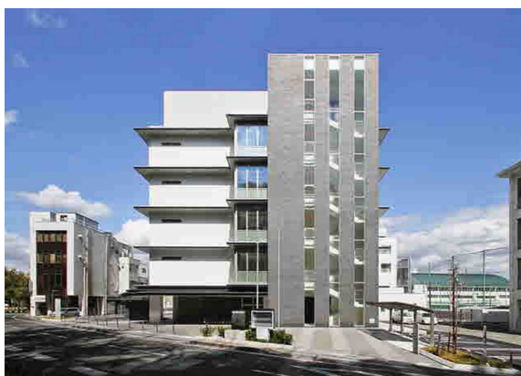
高知県保健衛生総合庁舎
