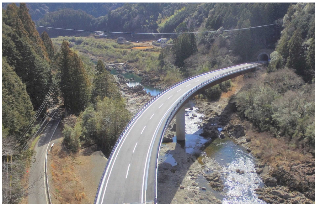
国道439号木屋ヶ内バイパス（四万十町）
