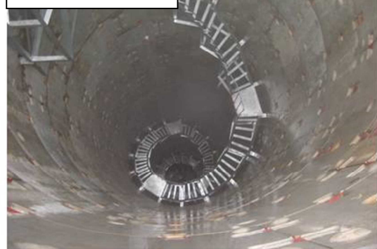
排水トンネル工の内部
