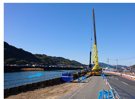
堤防の耐震補強を実施（下田川）
