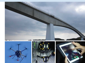
新技術を用いたインフラ施設の定期点検
