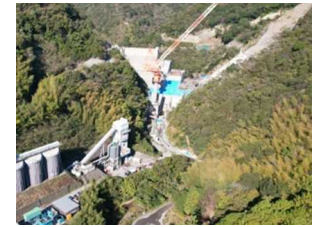
<建設中の和食ダム>
