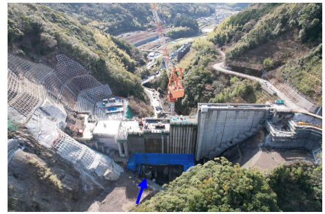
和食ダム 本体工事施工状況
