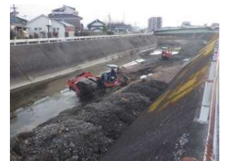
<河川に堆積した土砂の浚渫>
