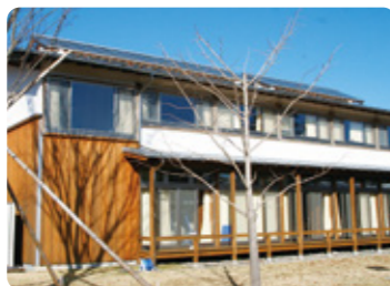
リハビリテーション病院すこやかな杜のウッドデッキ
