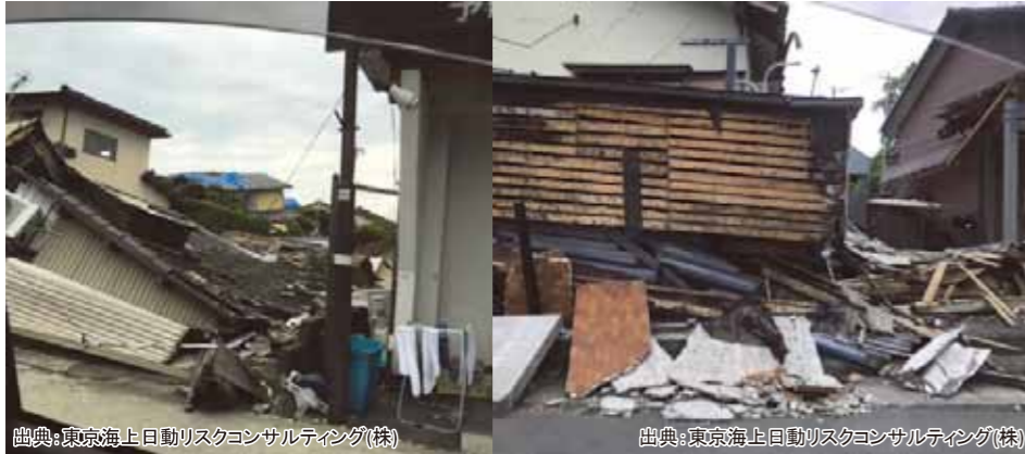
【熊本地震の建物被害】
