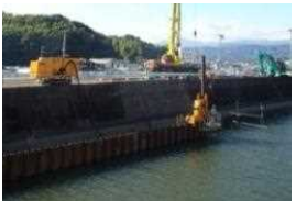
河川堤防の耐震対策
