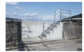
コンクリートによる陸こうの閉鎖
