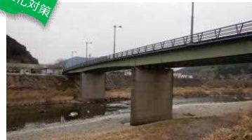
国道381号 窪川橋
