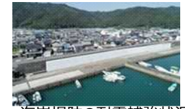
海岸堤防の耐震補強状況
