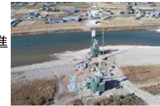
E55高知東部自動車道 南国安芸道路（香南市）
