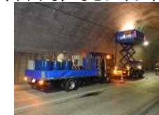
歯朶ノ浦トンネルの補修状況
