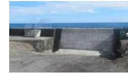
コンクリートによる陸こうの閉鎖
