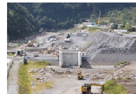
国道493号 (北川道路2-2工区)
