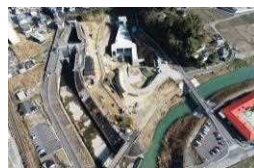
日下川（放水路整備）
