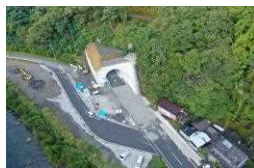
安田東洋線におけるトンネル整備
