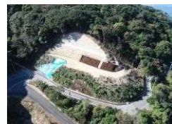
安満地福良線における線形改良
