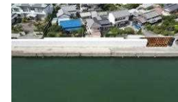
海岸堤防の耐震補強状況
