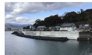
【高知港海岸】 (海岸堤防の耐震対策)
