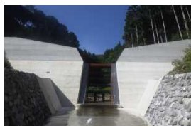
【中ノ川内川】 (砂防施設の整備)
