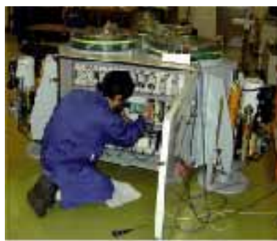
配線変更の様子
