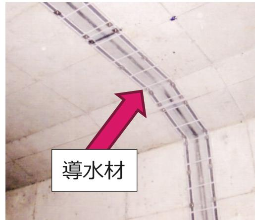
図 1 トンネル用導水材の施工状況
