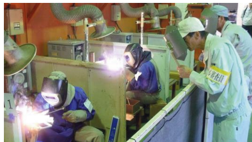
被覆アーク溶接の様子
