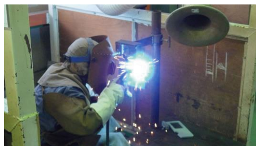
炭酸ガスアーク溶接の様子
