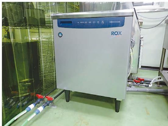
図1 次亜塩素酸水生成装置
