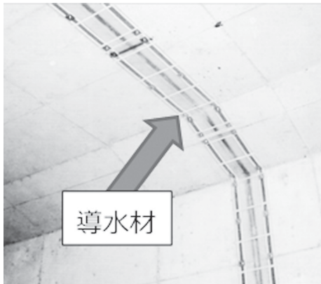
図 1 トンネル内で使用されている導水材
