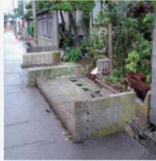
地震により、倒壊したブロック塀
