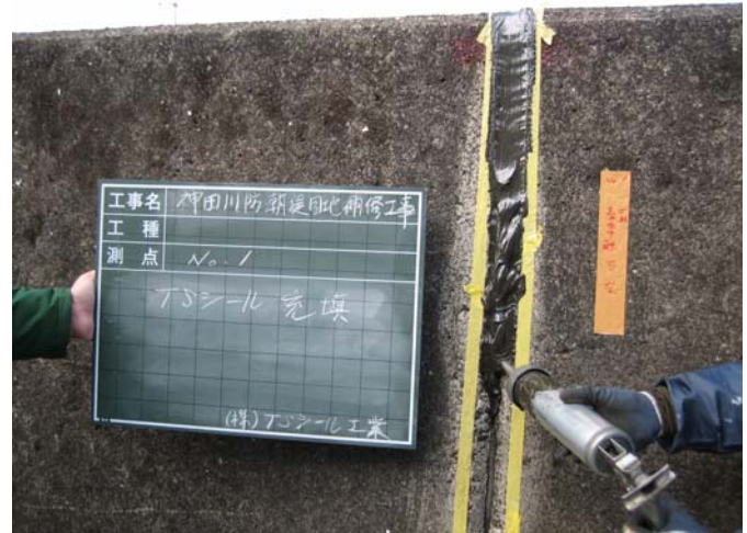
防潮堤接合目地部(高知市神田川)
