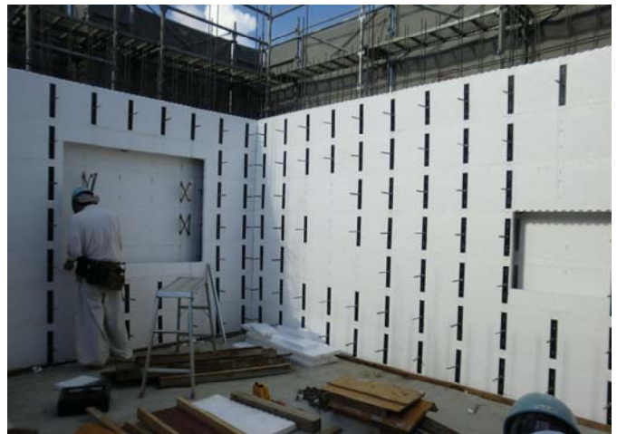
高知市にて施工中写真
