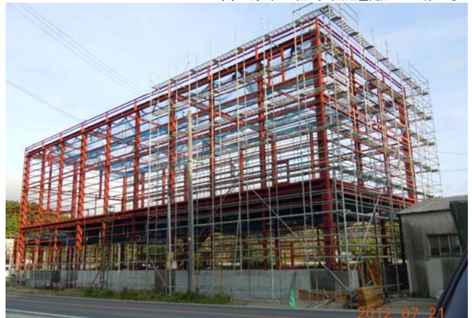
宮城県女川市 倉庫併用住宅新築工事
