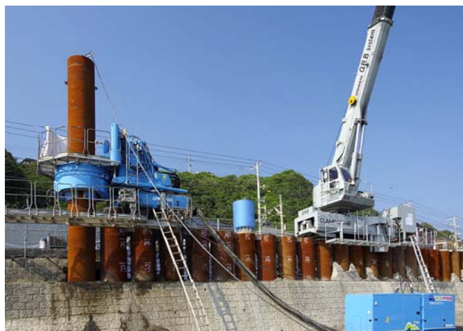
ジャイロプレス工法 & ノンステージング工法(海岸に面した道路擁壁改修)
