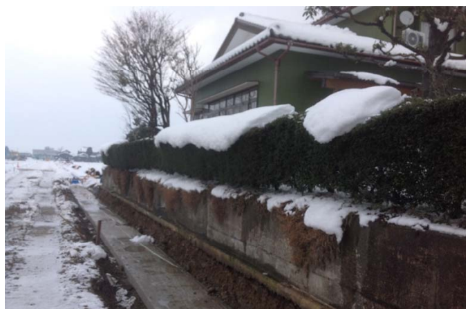
鋼矢板引き抜き後の復旧工事中 家屋擁壁、変位1~2mm、擁壁の養生なしで掘り下げ 水路用U字溝ベースコンクリートの施工がなされている
