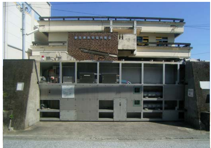
高知県高知市御量瀬漁港設置
