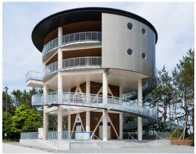
高知県中土佐町津波避難タワー第1号
