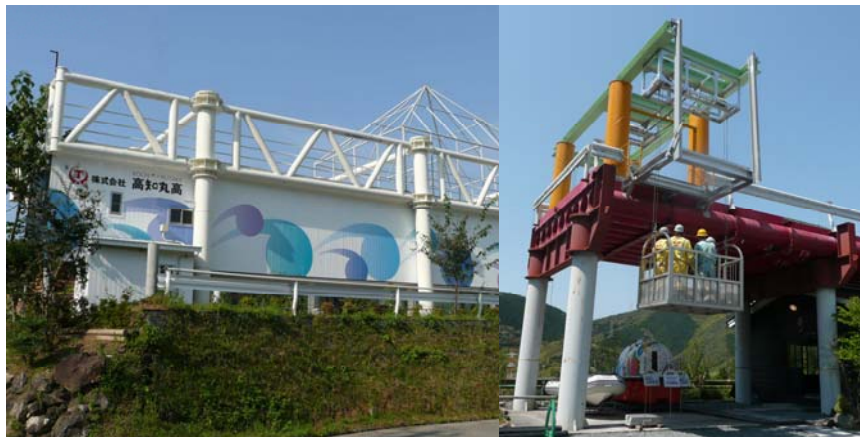
プラットホーム式津波避難タワー
