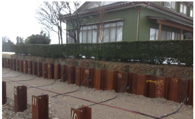
家屋近接工事による家屋への実害発生阻止に採用された例 掘削深さ約6.0m 仕上がり内径2.0mコンクリート管敷設 鋼矢板芯から家屋壁面までの距離3.5m 鋼矢板Ⅲ型
