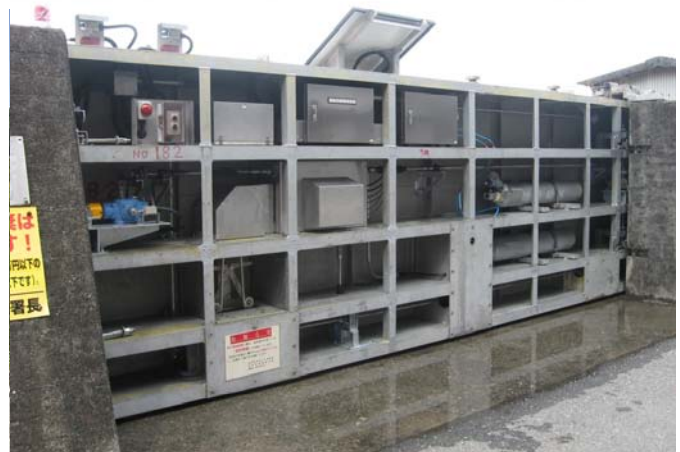
機器取付状況
