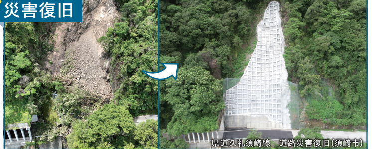
県道久礼須崎線 道路災害復旧(須崎市)
