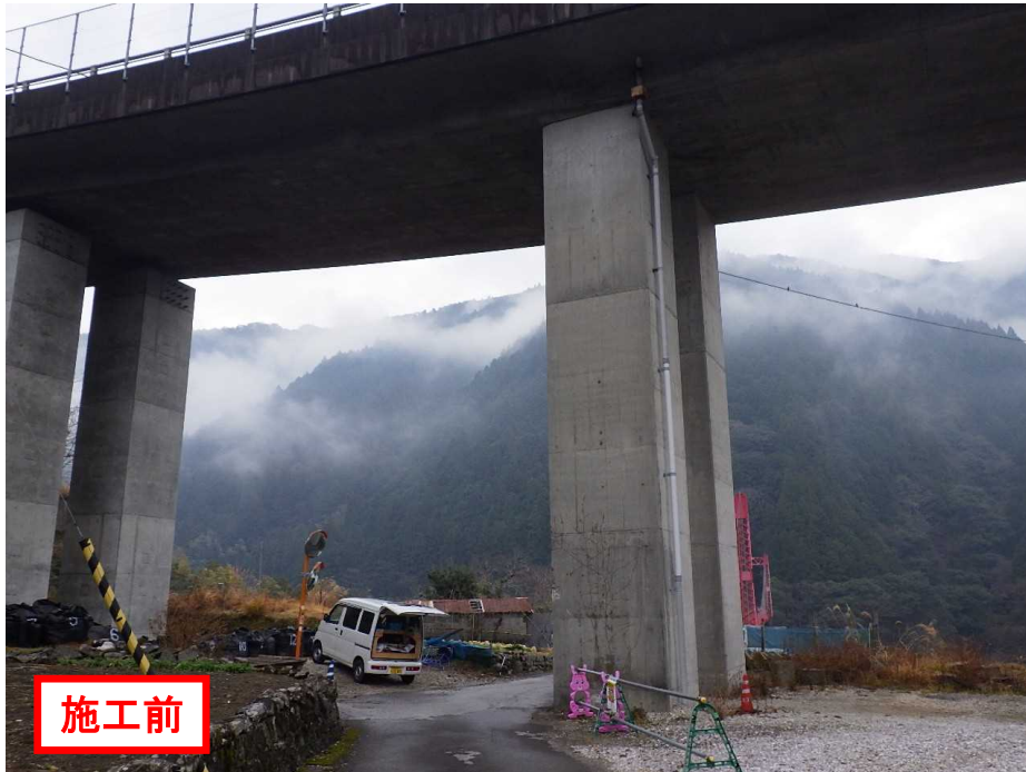
国道195号橋梁耐震補強工事(香美市:山崎陸橋)
