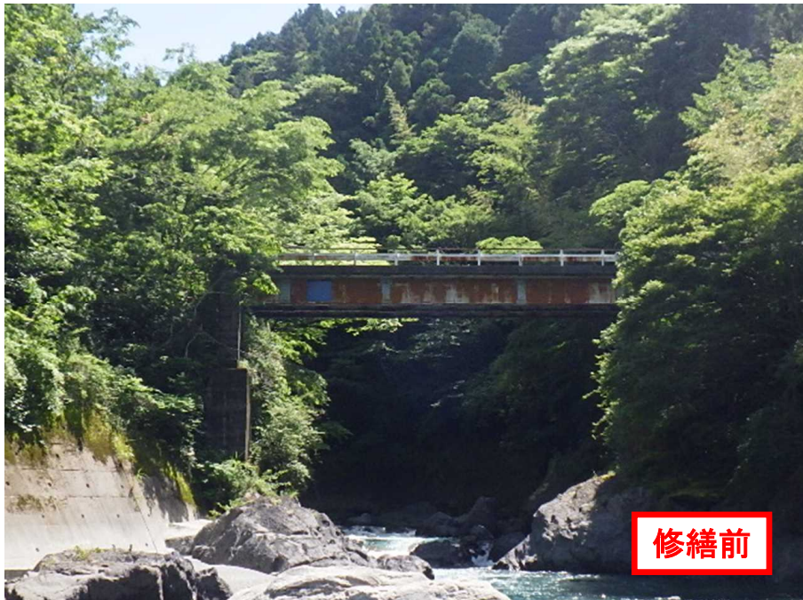
県道久保大宮線橋梁修繕工事(香美市:南池橋)
