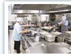
IHクッキングヒーターで加熱調理中。厨房内の高温化を防いでくれます。
