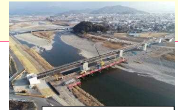
南国安芸道路 (高知龍馬空港IC ~香南のいちIC) ※土佐国道事務所提供
