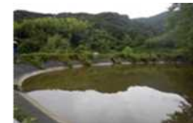
【宿毛市1期地区】 (ため池の耐震対策)
