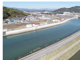
【下田川】 (河川堤防の耐震対策)
