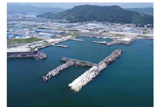
【高知港】 (港湾施設の地震・津波対策)
