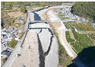
【安芸川】 (河川の堤防整備)
