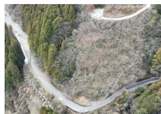
国道439号 川井拡幅工区 (大豊町)
