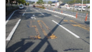
老朽化した舗装など
