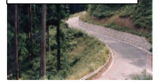
林道開設施工後
