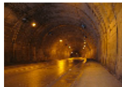
トンネル施設
