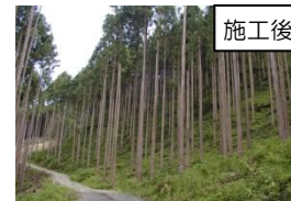
林道開設施工後
