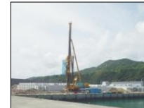
防災拠点漁港の岸壁耐震化
