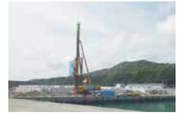
防災拠点漁港の岸壁耐震化
