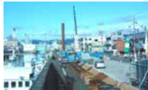
海岸堤防の耐震補強状況
