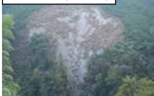
治山対策例（施工前）
