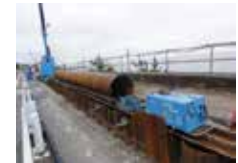
海岸堤防の耐震補強状況
