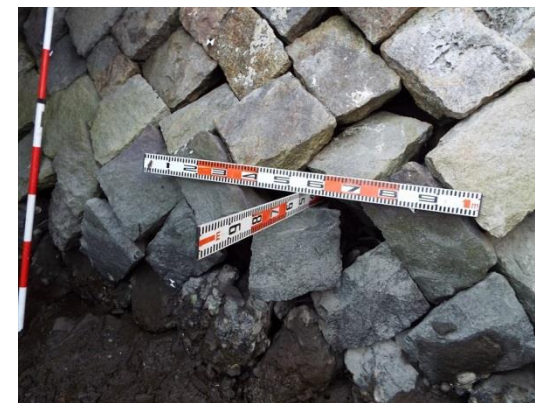
写真：石積下部の崩れ
