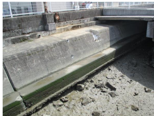
写真：対岸のコンクリート擁壁
