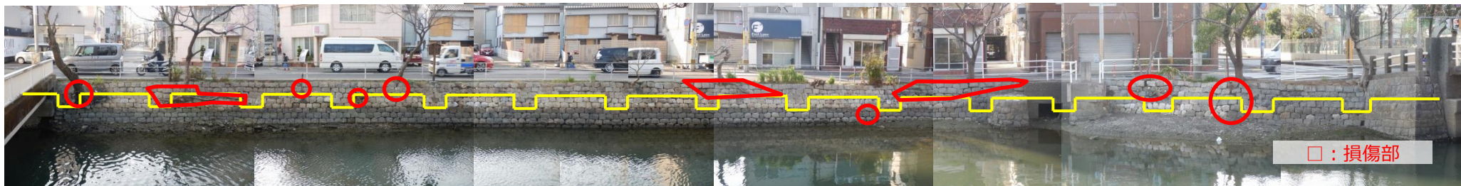
棧橋の影響箇所と樹木による損傷箇所図
