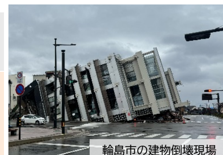
輪島市の建物倒壊現場
