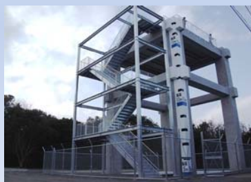
津波避難タワー
