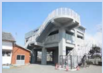
●津波避難タワー
