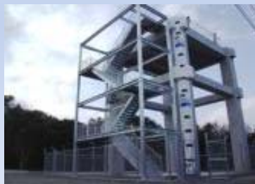
津波避難タワー
