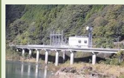
緊急輸送道路等における橋梁の耐震化
