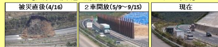
【大分自動車道（湯布院IC～日出JCT）の事例】
