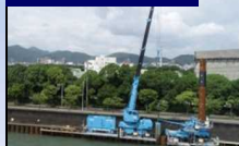
海岸堤防の耐震化
