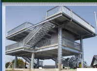
津波避難タワー
