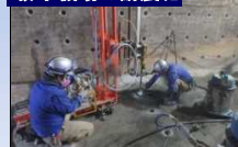
排水機場の耐震化
