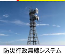
防災行政無線システム
