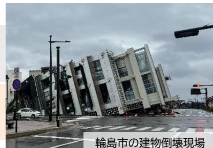
輪島市の建物倒壊現場
